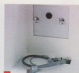
3 Отверстия в стенах шкафов для организации подачи и оттока воды размещать с запасом. Шланги для подпиточной машины подвести снизу.
