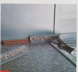
13 Повернувшись ударами установить между стеной и столешницей регулирующую рейку специального профиля и облицовочный пластиковый профиль.
