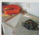
6 Прорезы в столешнице для монтажа раковины и плиты делают электроинструментами. Края срезов покрывают силиконом.
